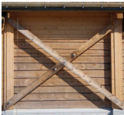
Vindavstiving, bjelker i kryss montert utvendig.
