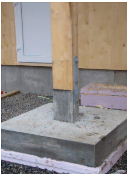
Fundamentering av søyle med beslag for forankring.
