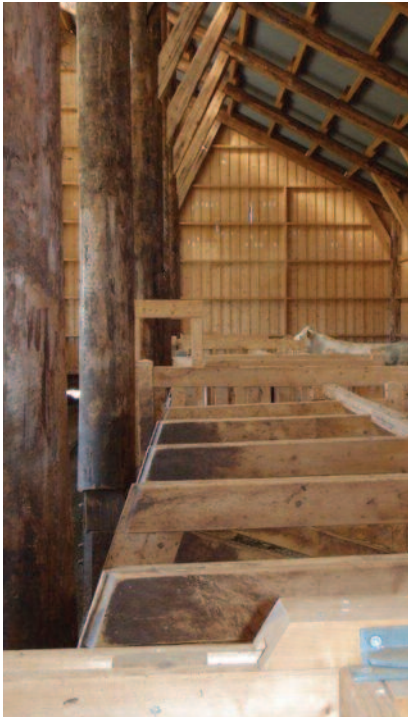
Pilotbygg i Grue, stolpekonstruksjon.
