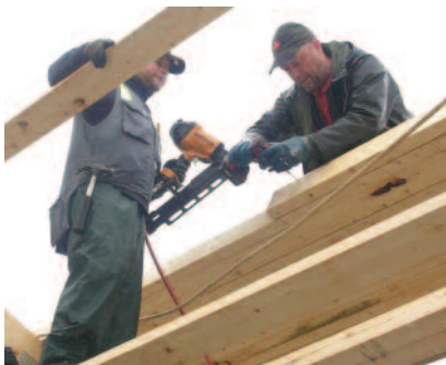
Pilotbygg i Rindal, montasje tak.
