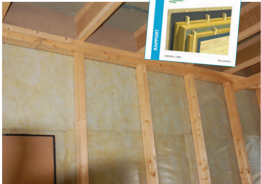
Oppbygging av dobbelt bindingsverk med inntrukket dampspærre.
