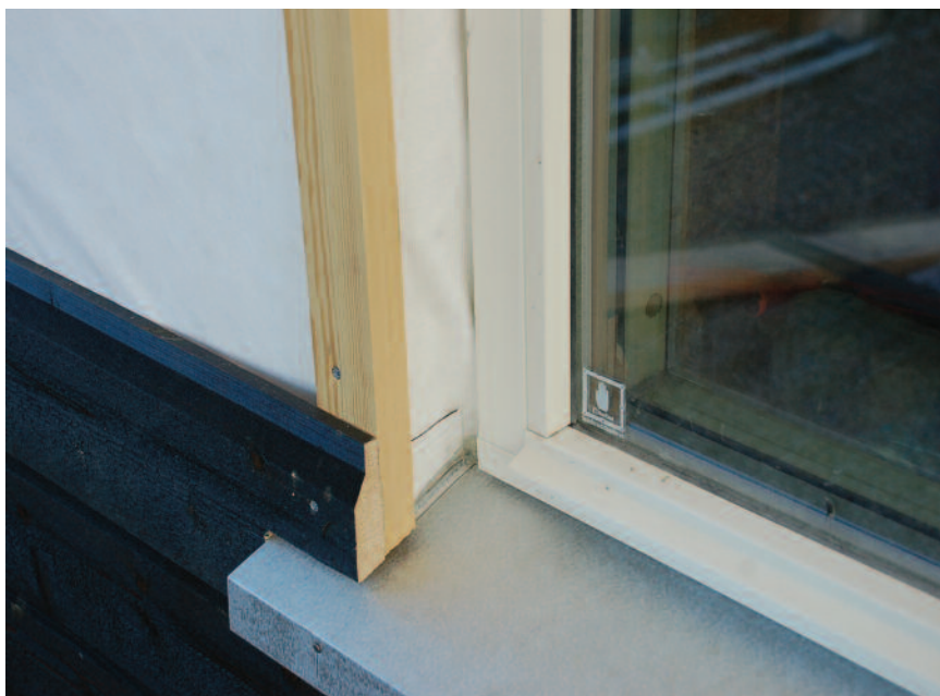
Eksempel på tetting rundt vindu.
