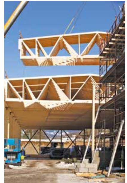
Ferdige takelementer heises på plass. (Pretre)
