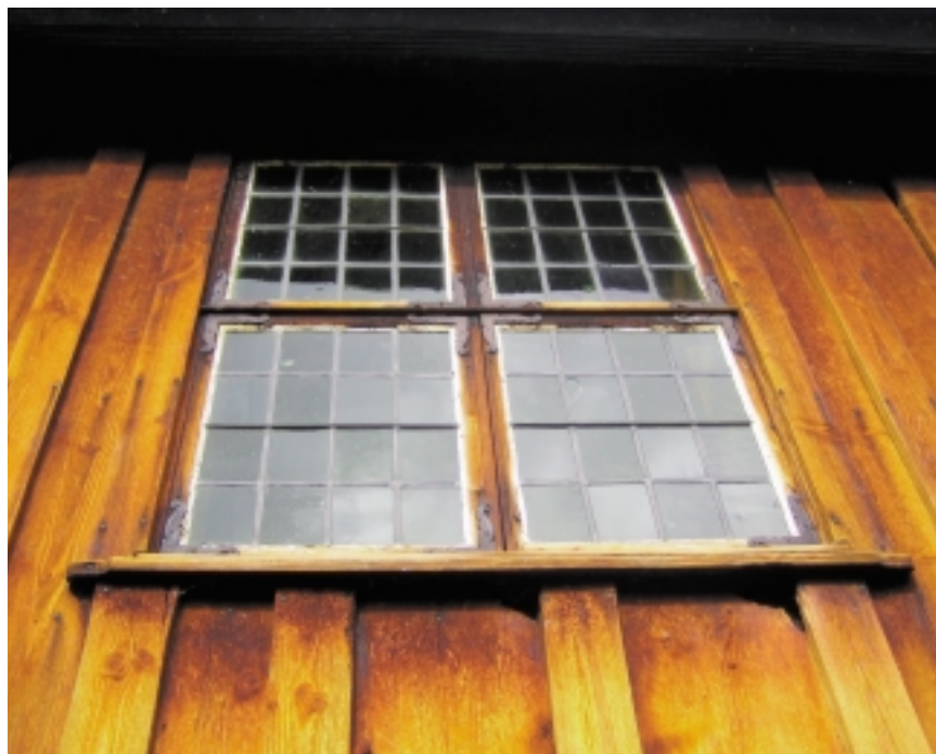
Vindu i kirke påført tjære.
