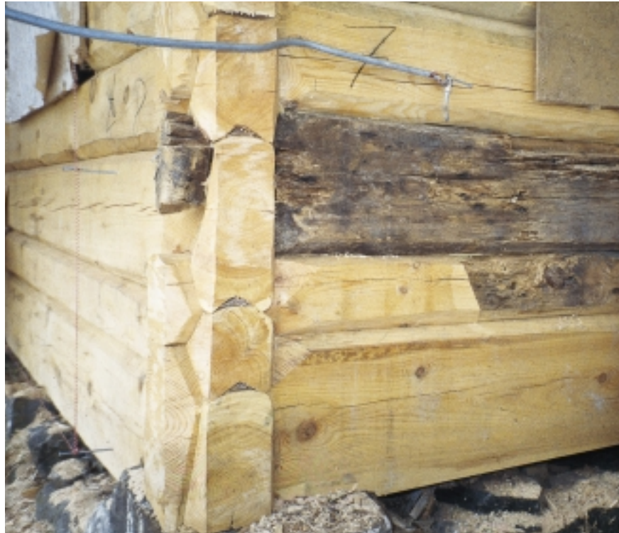
Eksempel på omfattende reparasjon av lafta hus. Det er brukt samme materialkvalitet og lafteteknikk ved restaurering som i opprinnelig bygning.
