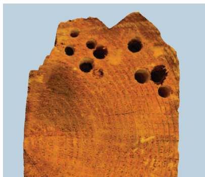
Figur 6. Kreosotimpregnert trevirke angrepet av pælemark i kjerneveden.
