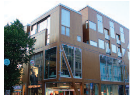
Midtbyen Trondheim - stål, hull-dekke og limtre. (Foto: Tore A. Sines)
