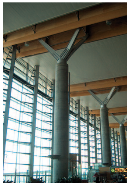
Gardermoen - betong, stål og limtre. (Foto: TreFokus AS)
