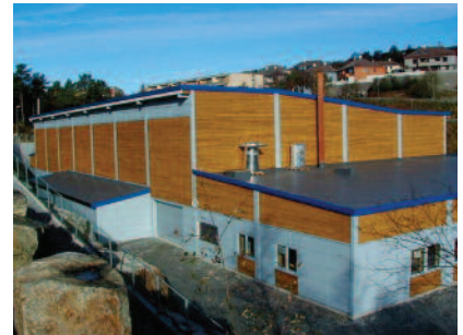
Royalimpregneret kledning, idretts-hall. (Foto: MøreTre AS)
