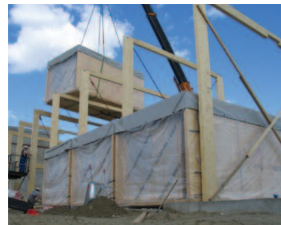
Limtre- og massivtrekonstruksjon, Viken senter Bardufoss. (Foto: Moelven Massivtre AS)
