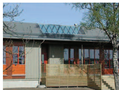
Tre og glasstak. (Foto: Moelven Byggmodul AS)
