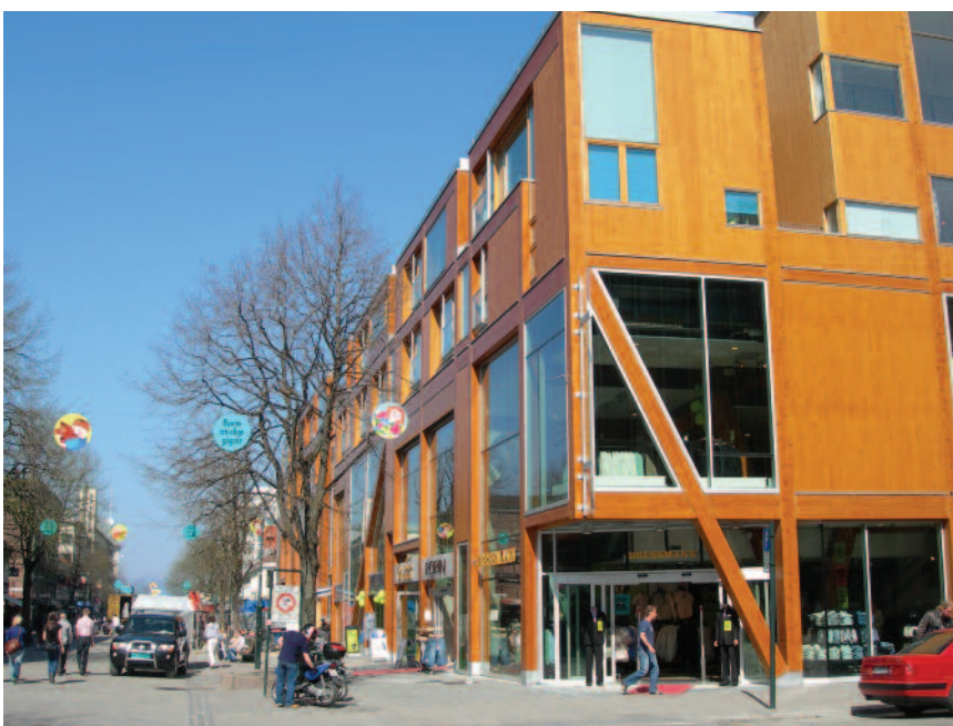
Midtbyen i Trondheim - stål, hulldekke og limtre. (Foto: Treteknisk)
