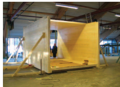
Trebasert modulbyggeri i massivtre. (Foto: Moelven Massivtre AS/ Moelven Byggmodul AS)
